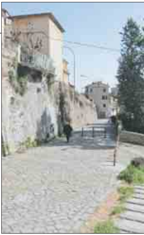
L'area dove dovrebbe sorgere l'ascensore
